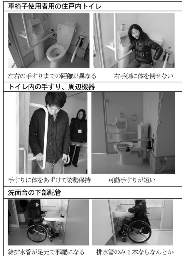
図4 車いす対応住戸のトイレ・洗面所
