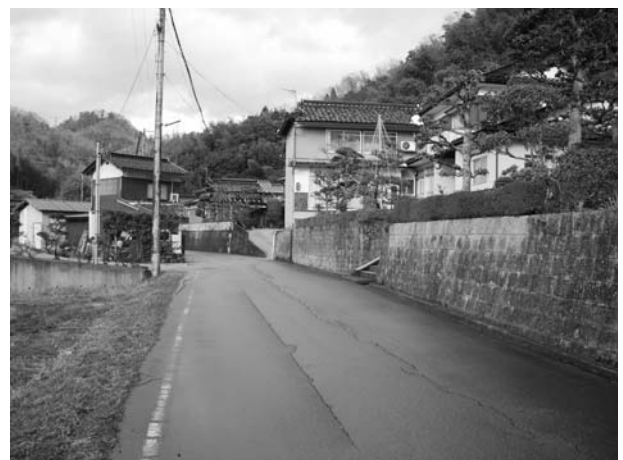
図4 新田地区河谷区の宅地擁壁
