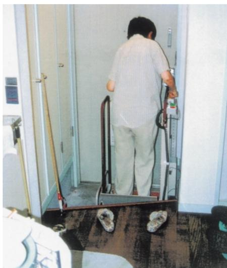
写真 4：段差解消機での昇降動作
