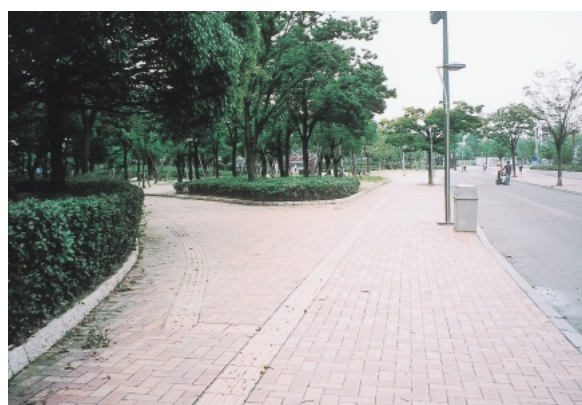
歩道上の分岐する点字ブロック
