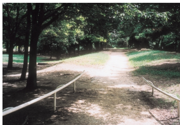
散策路交差部のガイドパイプと点字ブロック
