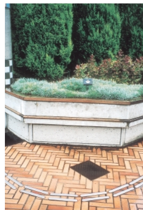
後から設置された点字ブロック
