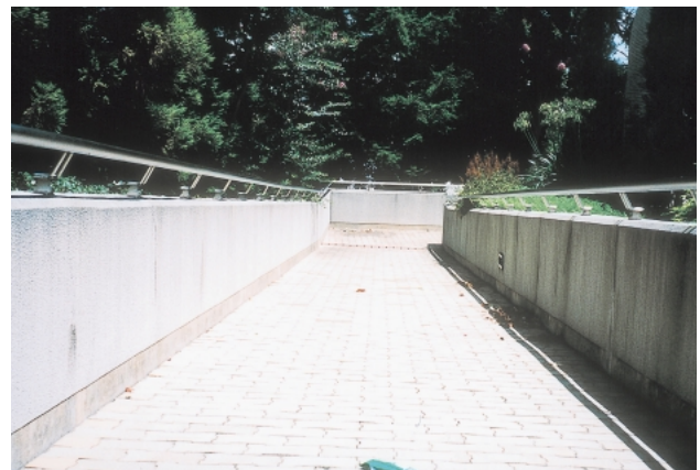
スロープと使いやすい手すり
